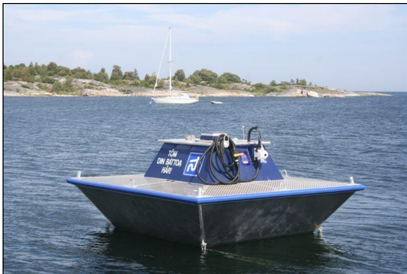
Bild 36: Tanktömningsanläggning för fritidsbåtar vid Huvudskär. Foto: Pontus Holmström
