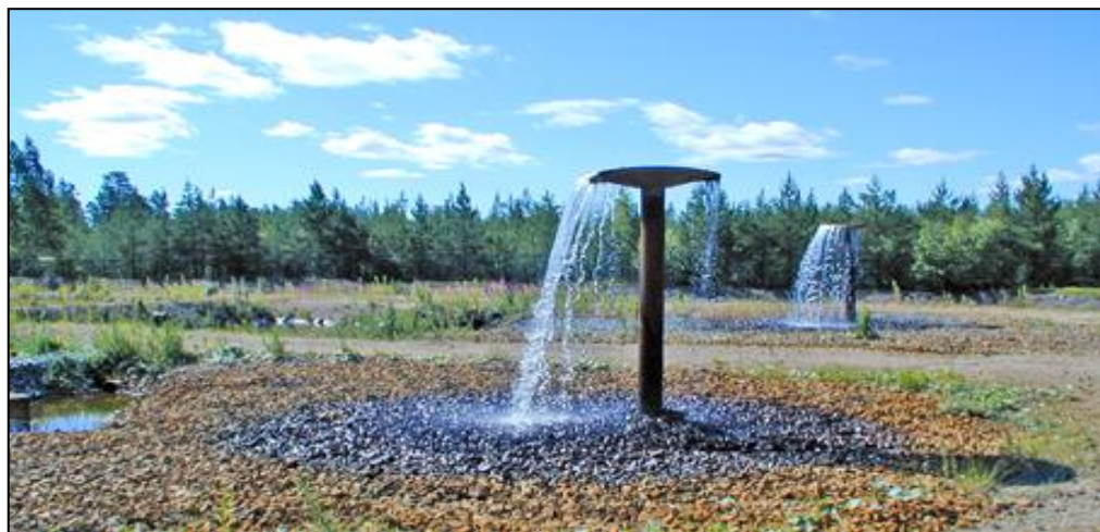
Bild 23: Pålamalms vattenverk i Tungelsta är ett av Haninge kommuns fyra grundvattenverk Foto: Haninge kommuns bildarkiv
