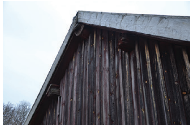
Mälby Norrgård: Gavelröstets detaljer skvallrar om att byggnaden kan vara mycket gammal. Ryggåsstugan är en ålderdomlig företeelse som i huvudsak tillhör perioden innan 1700-talet. Foto: Tobias Mårud.
