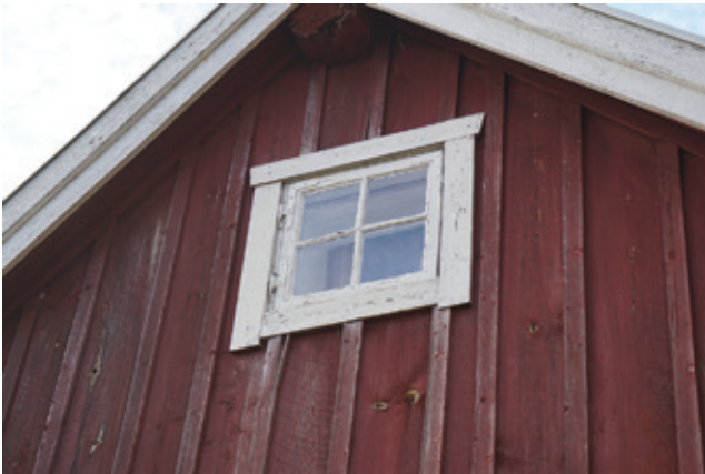
Örnstorp. Fönster med beslag från 1800-talets senare hälft. Foto: Tobias Mårud.
