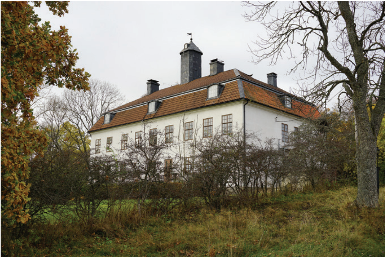
Ludvigsberg, södra fasaden, hösten 2015. Foto: Tobias Mårud.
