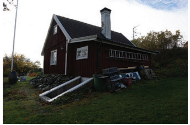
Örnstorp. Den höga skorstenen är vanlig under 1700-talet, flera exempel på liknande skorstenar finns på Muskö. Foto: Tobias Mårud.
