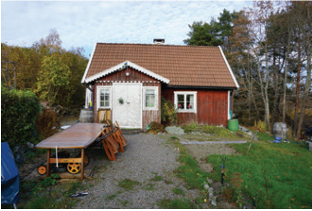
Örnstorp. Torpstugan sedd från söder. Foto: Tobias Mårud.
