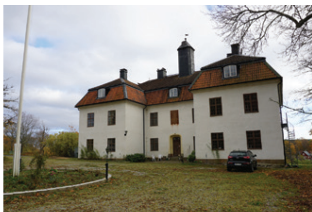
Ludvigsberg, norra fasaden sedd från gårdsplanen, hösten 2015. Foto: Tobias Mårud.
