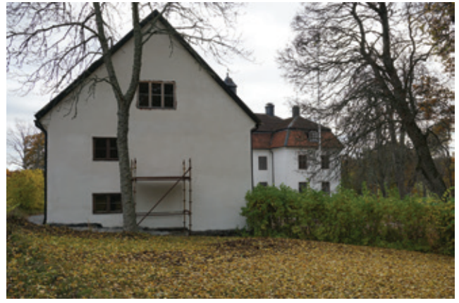
Den bevarade flygeln, norra gaveln, med manbyggnaden i bakgrunden, hösten 2015. Foto: Tobias Mårud.
